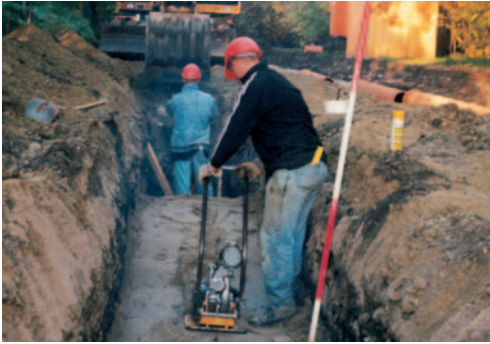
Tätigkeitsgruppe Kanal- und Rohrleitungsbauer
